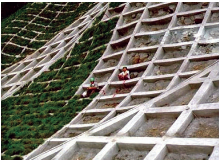
Mynd 10.16. Verkfræðilegar aðgerðir til að hamla skriðuföllum á nýgerðan veg um hálendi Hokkaídó-eyju í Japan. Japanir reyna einnig að halda í öflugra skógarhulu í fjallshlíðum til að minnka hættu á skriðum.
